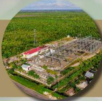
Pembangkit Listrik Power Plant
